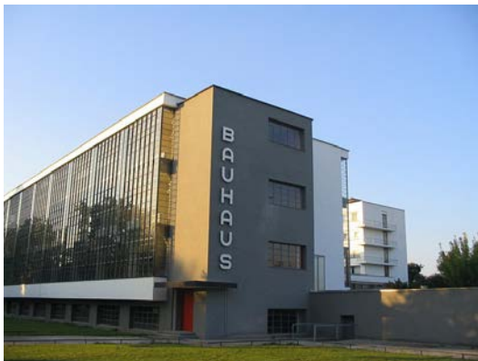
Edificio diseñado por W. Gropius en Dessau (1925-1926)
